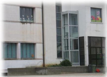
Il nuovo ascensore delle scuole elementari di S.Cipriano
