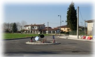
I lavori di Via Trento-Trieste
